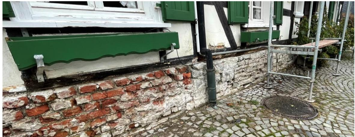
Die Gerüste wurden für die Abbrucharbeiten und die Bauschadensuntersuchung vor Ort aufgestellt und werden sukzessive verrückt. Nach Abbruch der Verkleidungen werden die Fassaden bei Bedarf mit Folie gesichert.
