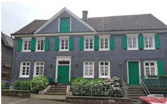
Abbildung 38: Wohngebäude an der Hauptstraße
