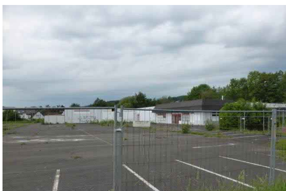
Abbildung 34: Toom-Gelände an der Othestraße
