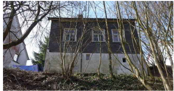
Abbildung 45: Baufälliges Haus in der Altstadt
